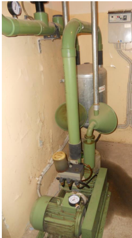
43 pav. WestfaliaSurge firmos vakuomo aparatūra.
