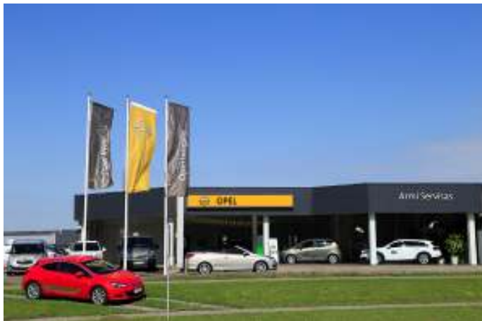
4 pav. Armi Servisas Klaipėdoje
