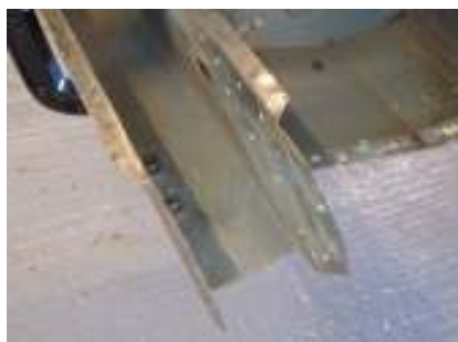
23 pav. Sustiprinimo elementų demontavimas
