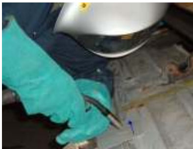
18 pav. Degiklio ir suvirintojo pozicija
