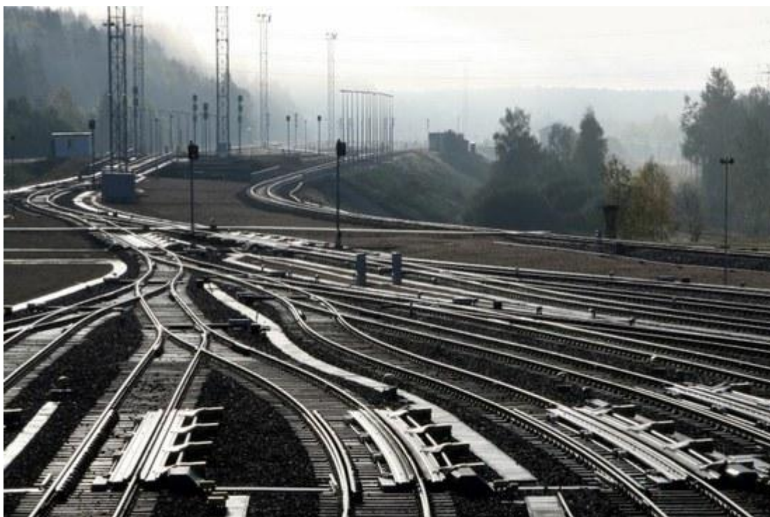
41 pav. Vaidotų geležinkelio stoties skirstymo kalnelio iešmynas
