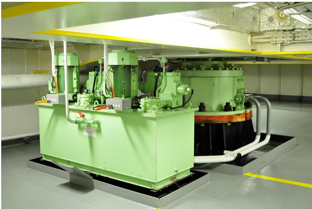
37 pav. „VICTORIJA SEAWAYS“ vairavimo mašina
