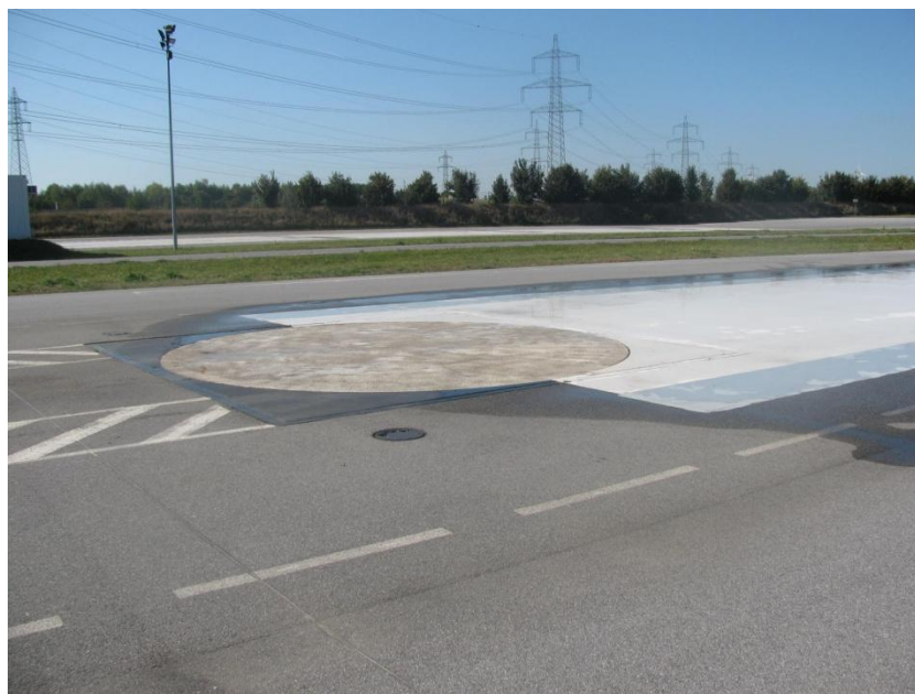
7 pav. Dinaminė stabdymo zona su nuolatine slydimo trasa lengviesiems automobiliams
