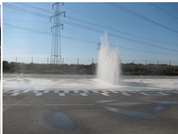
9 pav. Dinaminė stabdymo zona su nuolatine slydimo trasa krovininiams automobiliams ir autobusams
