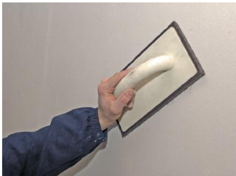
15 pav. Viršutinio sluoksnio užtrynimas
