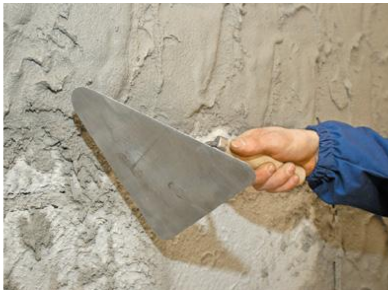
13 pav. Viršutinio sluoksnio klojimas
