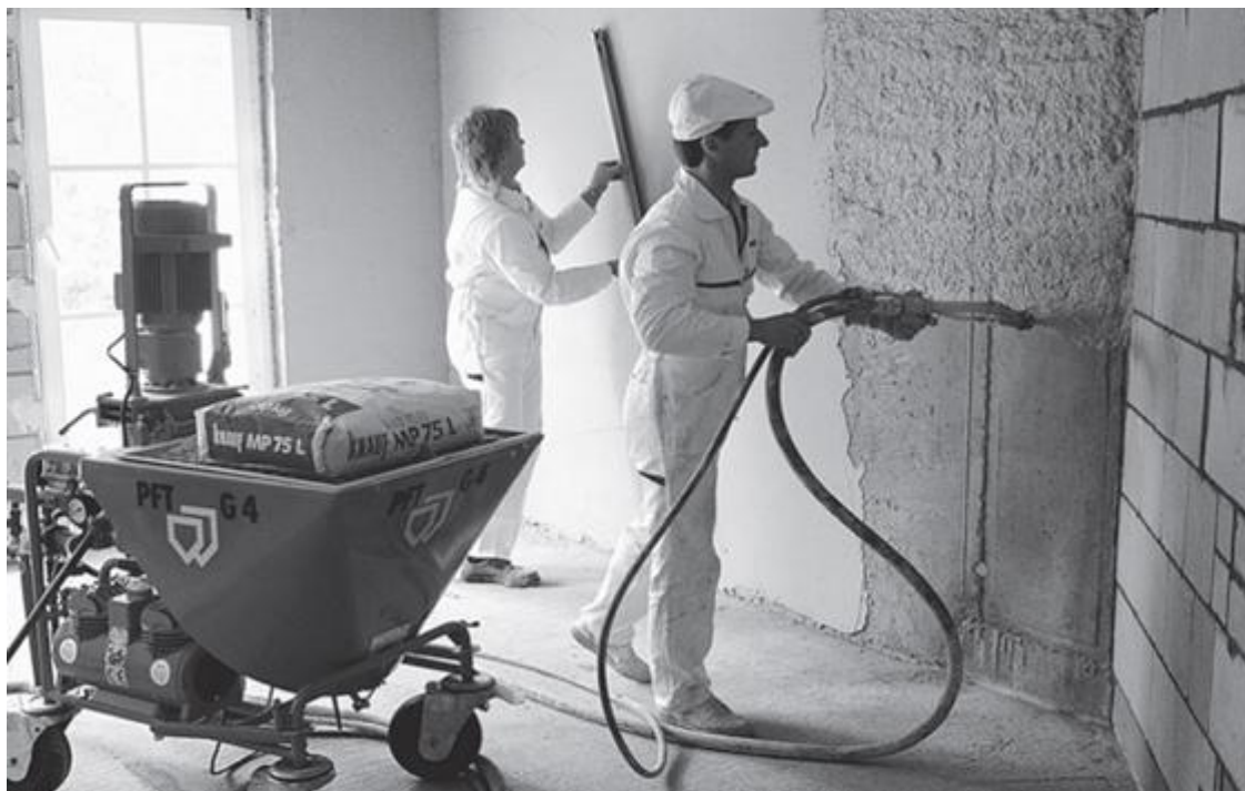
6 pav. Mechanizuotas tinkavimas knauf MP 75 mišiniu
