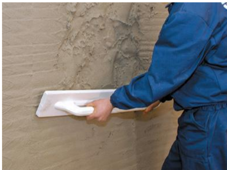
14 pav. Viršutinio sluoksnio išlyginimas
