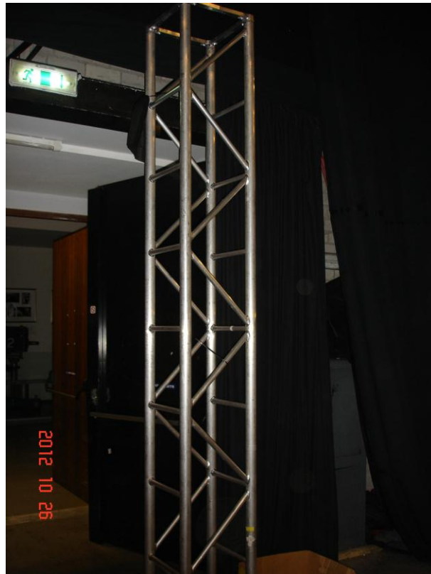
43. pav. Apšvietimo stovų konstrukcijos
