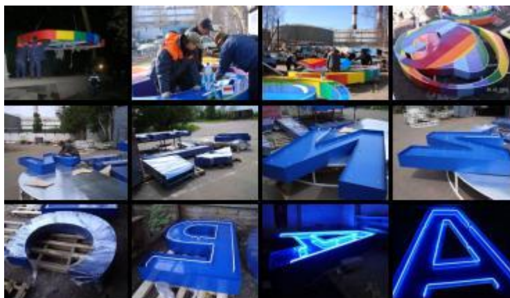
106 pav. Išorinės šviečiančios reklamos montavimo darbai.
