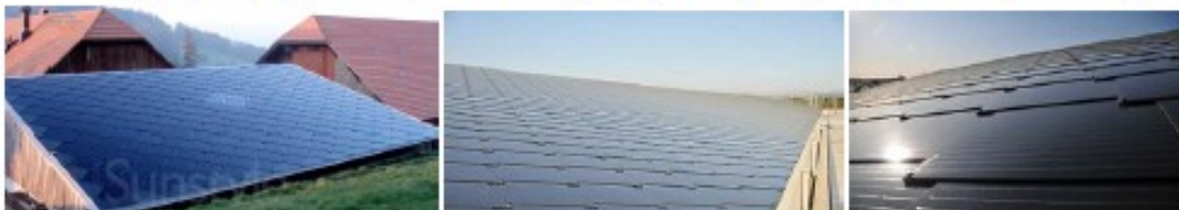
Foto: 20 kWp galios jėgainė.
