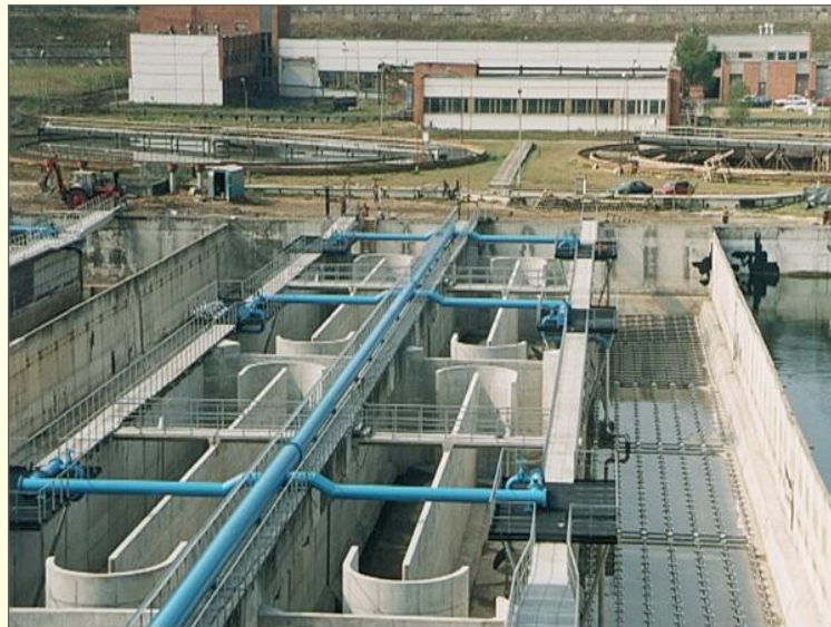
UAB „Vilniaus vandenų“ rekonstrukcija.
