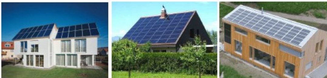
Foto: 6 kWp galios jėgainė
