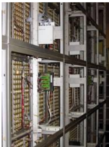
Pav. 4 - Rekonstruoto skydo konstrukcijos fragmentas.
