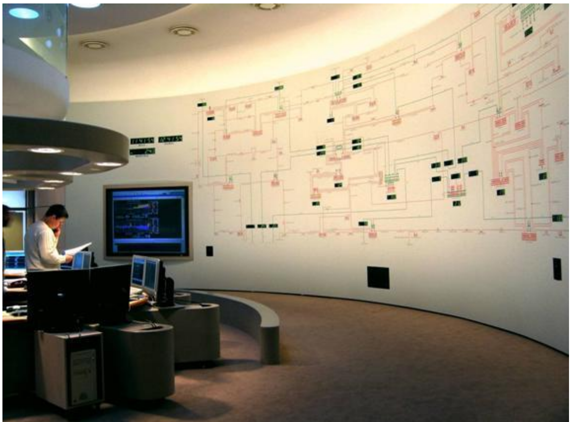
Pav. 6 Dispečerinio skydo su informacijos iš SCADA sistemos išvedimu ir videosienos integracija pavyzdys.
