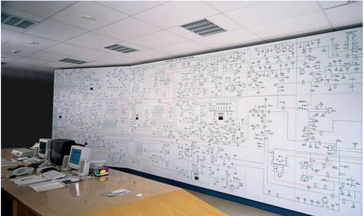
Pav. 5 Dispečerinio skydo su informacijos iš SCADA sistemos išvedimu pavyzdys.
